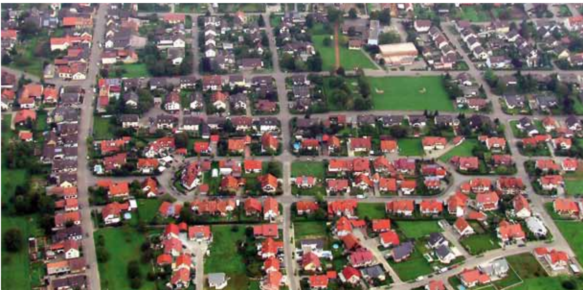
Im Luftbild werden Baulücken in Grafen- hausen sichtbar
